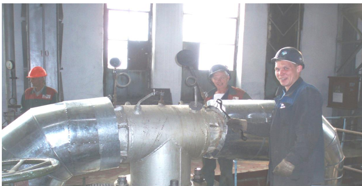
На снимке в присутствии куратора по монтажу т/а №2, Рыльского Василия Фёдоровича, первый справа и мастера по ремонту турбинного, цеха Кузмина Владимира Георгиевича, производится установка узлов по подаче пара от котлоагрегатов слесарем турбинного цеха, Шакнерс Алесандром Арвидсовичем.
